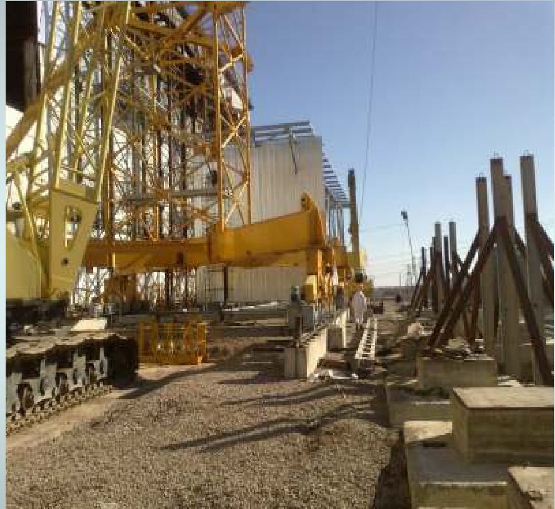
Монтаж просторанственного блока покрытия и крана «ПОТЕЙН» на пионерной стене.
