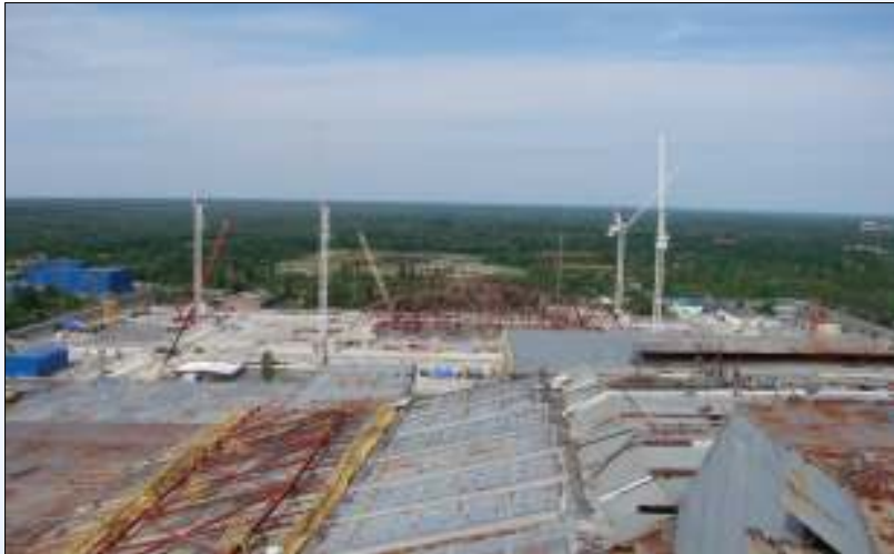
Монтаж перших конструкцій Арки
