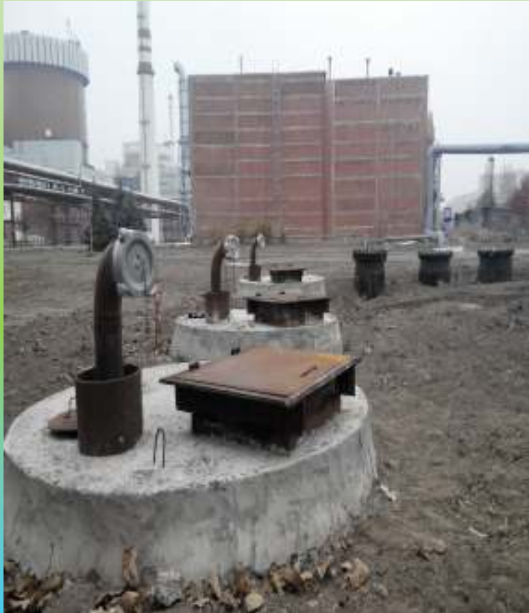
Место подключения (с гайкой «Богданова») МНУ-320 для подпитки ответственных потребителей технической воды группы «А»
