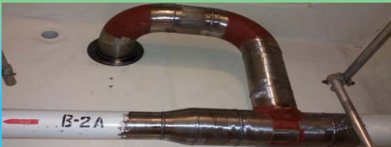
Врезка в бетонный венткороб
