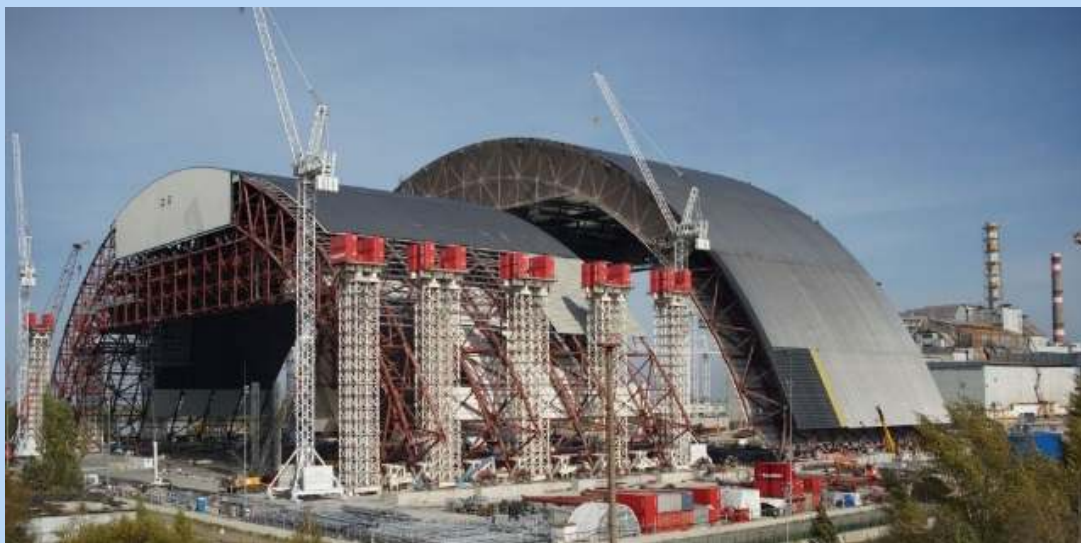
2-й підйом західної арки
