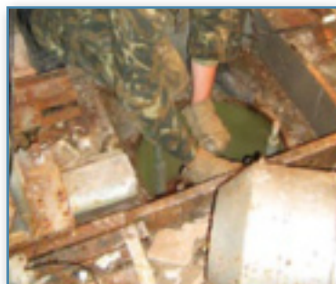
Вилучення ДІВ з установки КИС-РД
