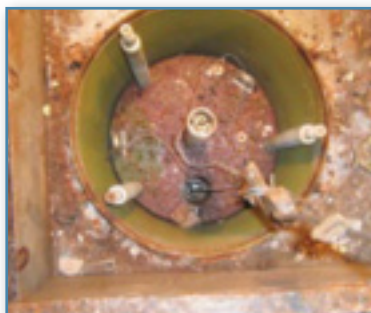
Установка КИС-РД після демонтажу
