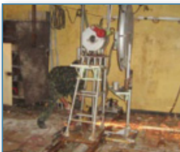
Демонтаж установки КИС-РД
