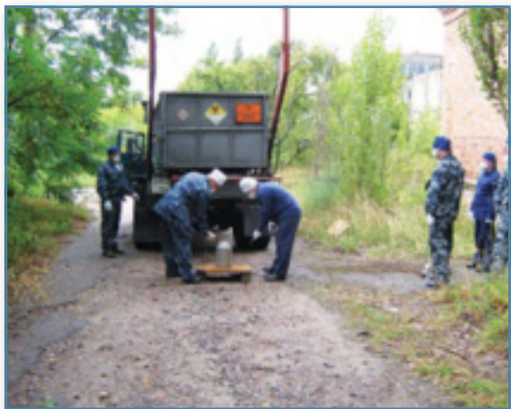
Завантаження радіоактивних відходів на спеціалізований автотранспорт
