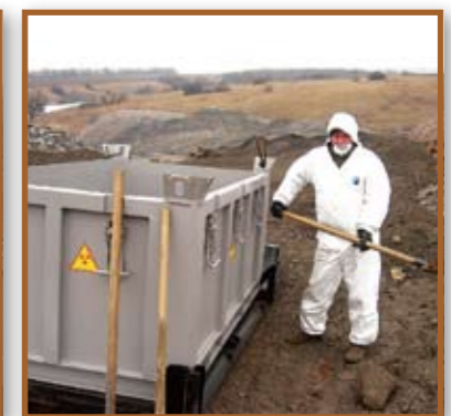
Извлечение радиационно-загрязненного шлака вручную
