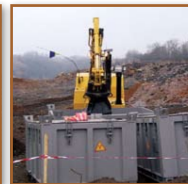
Извлечение радиационно-загрязненного шлака дистанционно-направляемым комплексом
