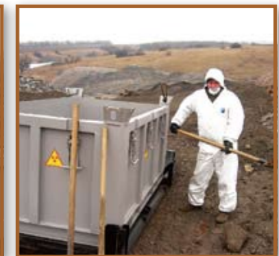
Вилучення радіаційно-забрудненого шлаку вручну
