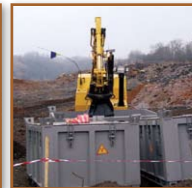
Вилучення радіаційно-забрудненого шлаку дійстанційно-керованим комплексом
