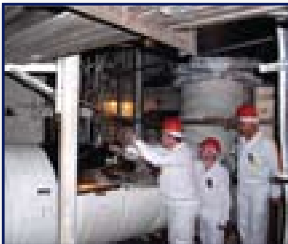
Заміна теплоізоляції на петлі №4 блока №1 ЮУАЕС
