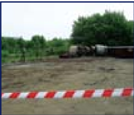
Хвостосховище «Південно-східне», майданчик для зберігання демонтованого обладнання
