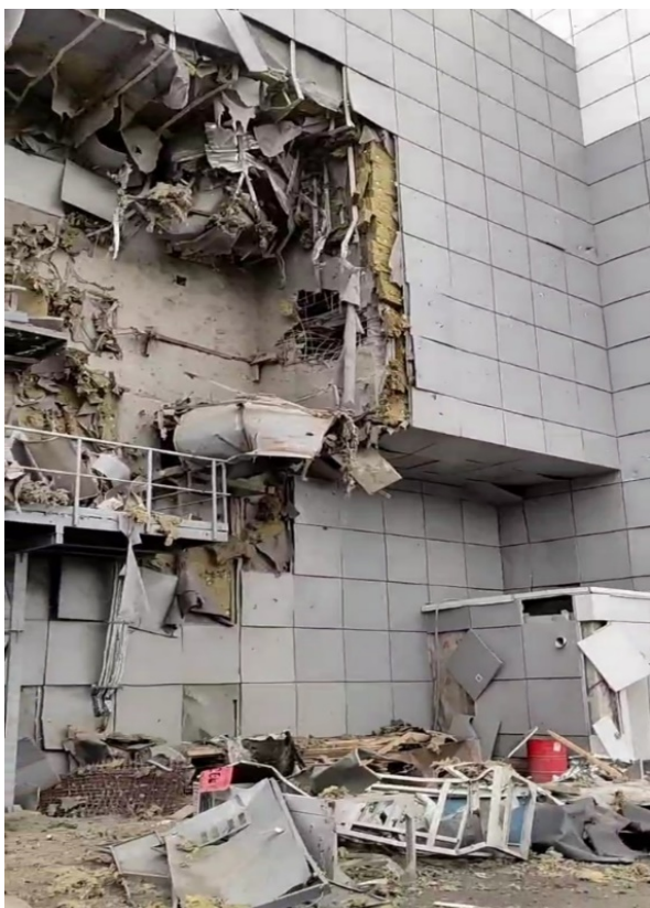
Фото 3 – Пошкодження основної будівлі ЯПУ «Джерело нейтронів»
