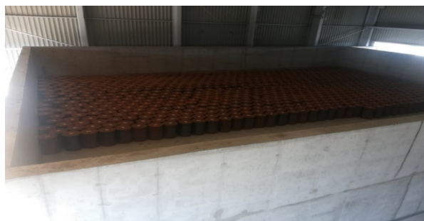
Фото 11 – Заповнення 5-го ярусу модуля Д1 СОПСТРВ
