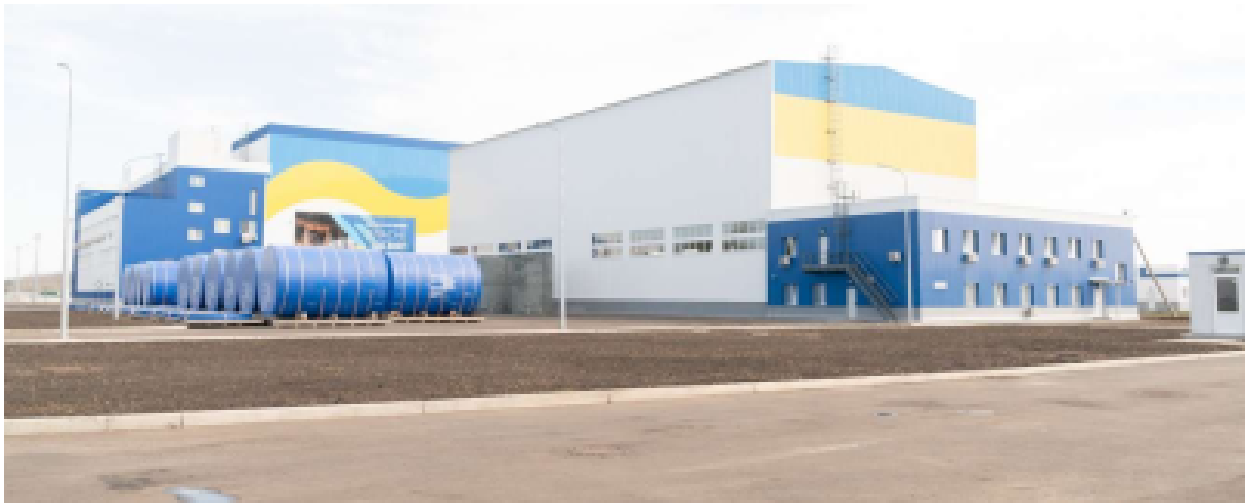
Фото 2 – Майданчик ЦСВЯП (будівля техобслуговування, будівля приймання)
