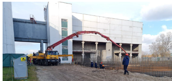
Фото 7 – Заливка фундаменту КПРАВ ХАЕС
